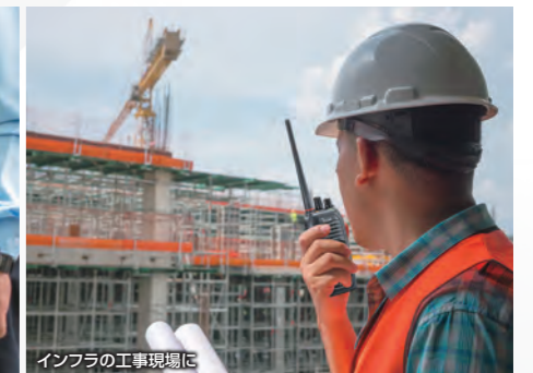
インフラの工事現場に
