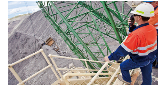
土木・建設事業で
